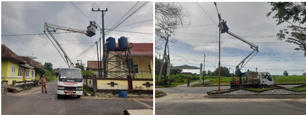
Gambar 3. 1 Pemeliharaan Lampu Penerangan Jalan Umum
