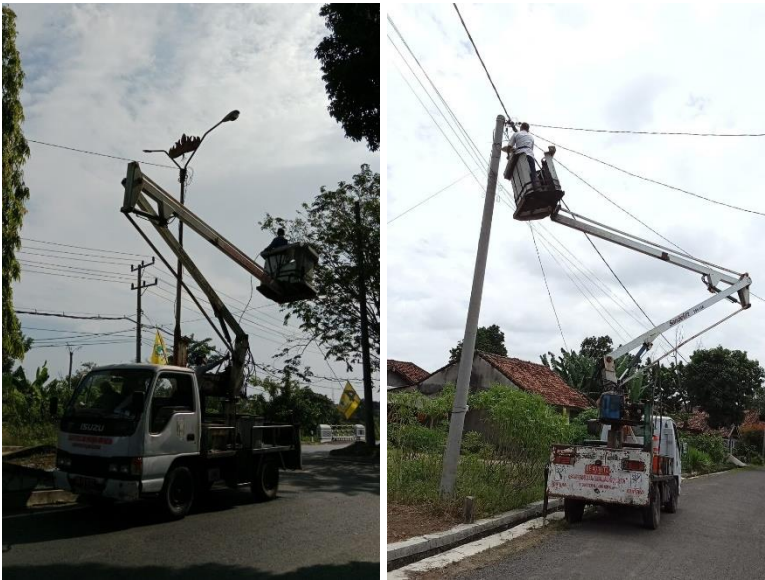
Gambar 3.1 Pemeliharaan Lampu Penerangan Jalan Umum
